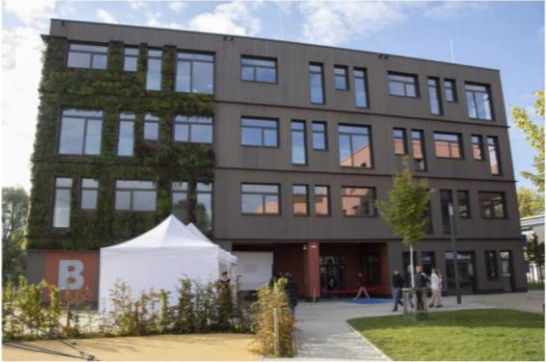
Das Erweiterungsgebäude ist in nur 13 Monaten Bauzeit entstanden. (Fotos: Wir in Dortmund)
